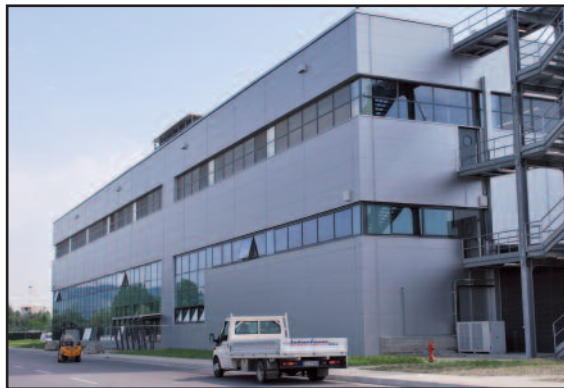
Stabilimento produttivo Ferrero (Alba, CN).
