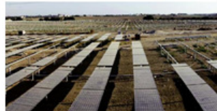
La mega centrale fv a Montalto di Castro
