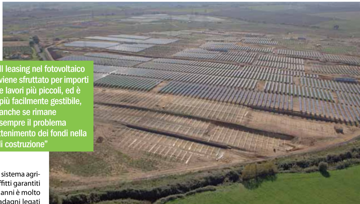
Vista aerea Parco eolico di Montalto di Castro (Viterbo).
